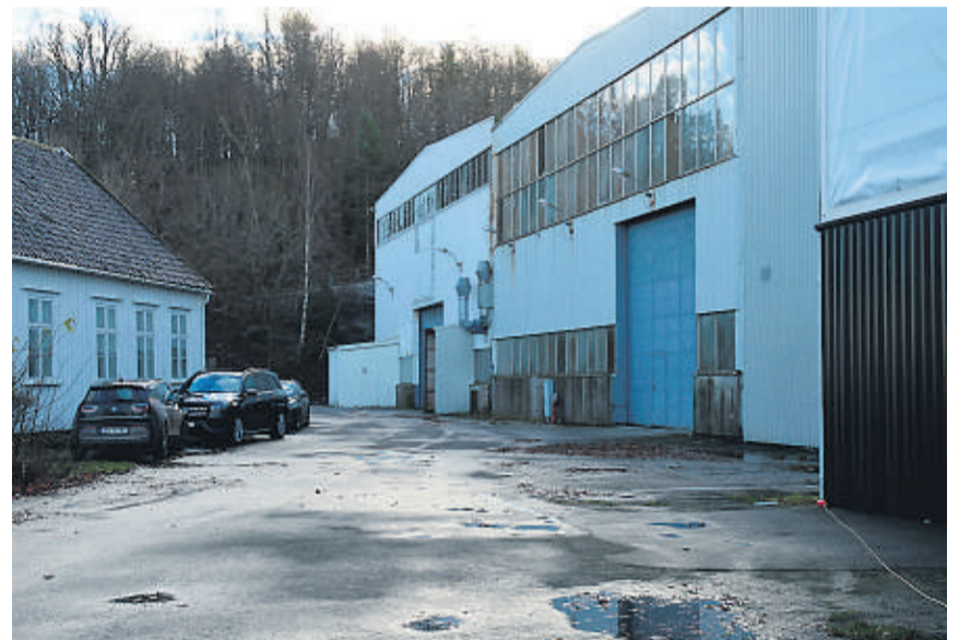
GRÅTT: Slik ser store deler av området på Pusnes ut i dag.
